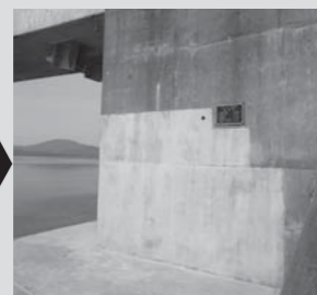
(3号橋橋台壁面の落書き清掃後)
