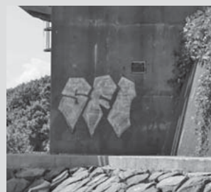
(3号橋橋台壁面の落書き)
