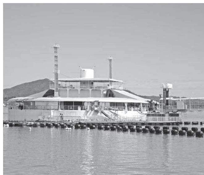
▲海に浮かぶ水族館は西日本でここだけ!
