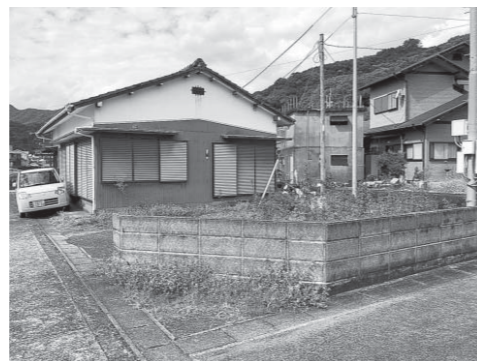
物件1 旧元釜教員住宅
