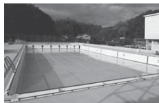
▲五和中学校プール
