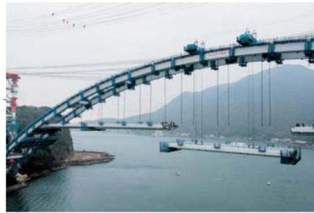
2017 1・2月 橋桁部分を閉じる(補剛桁架設) 写真提供：熊本県
