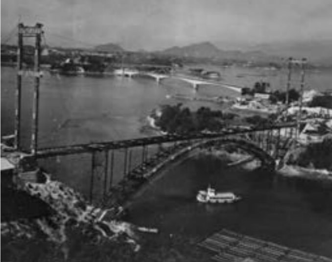
開通前、建設中の5号橋（益元喜久男さん提供）
