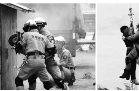
▲小型カメラで家屋の中を調査した後、エンジンカッター（切斤器具）で外壁を切斤し取り残された人を救出
