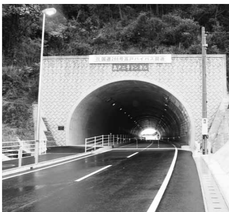
○12月に開通した高戸二号トンネル
