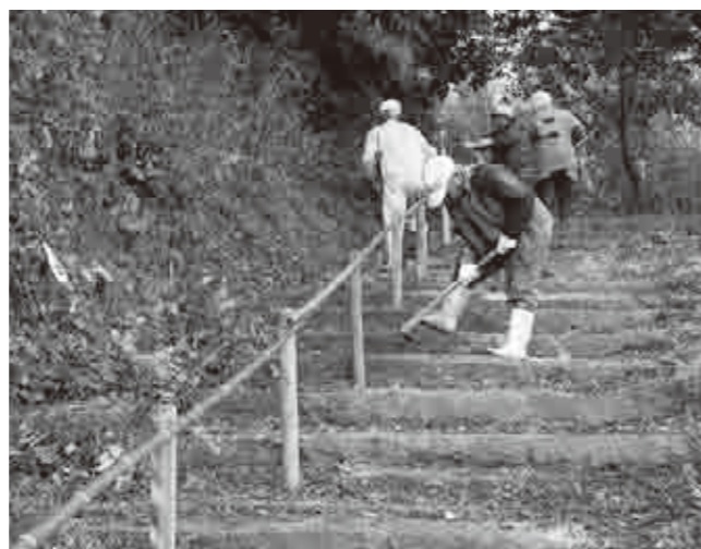
▲手すりなどが整備された参道
