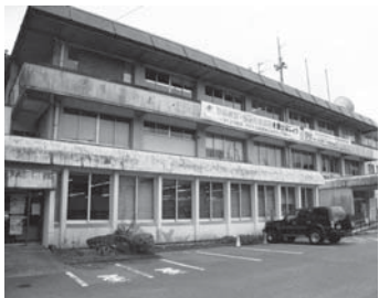
▲老朽化が進む現松島庁舎
