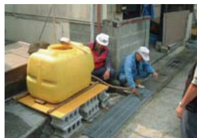
下水への放流状況
