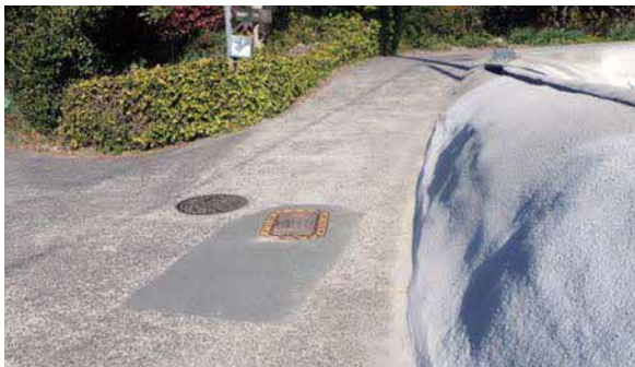
▲消火栓取替修繕（阿村地区）
