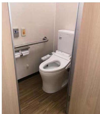
▲改修された学校のトイレ
