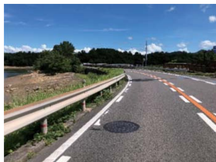
▲国道266号の3号橋から4号橋間
