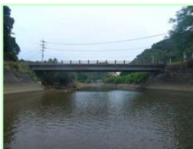
倉江橋（松島） 修繕：橋面防水工、 伸縮装置取替工等
