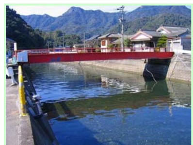
第二神代橋（姫戸） 修繕：床版打替え工 コンクリート補修工等
