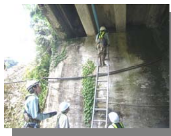
橋の定期点検状況(2)
