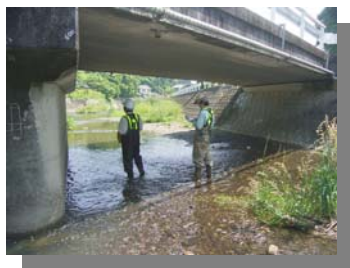
橋の定期点検状況(1)
