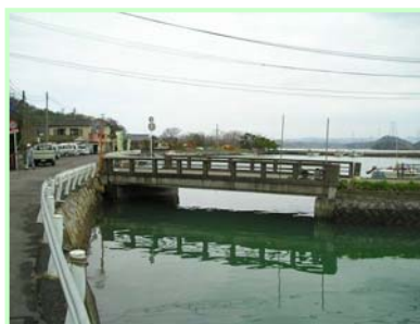
蔵々橋（大矢野） 修繕：コンクリート補修工 伸縮装置取替工等
