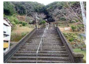
トンネル上部の状況
