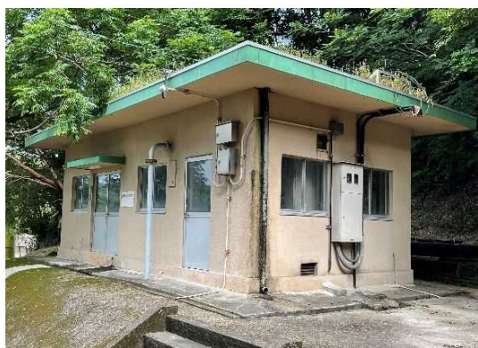
西部ポンプ場
