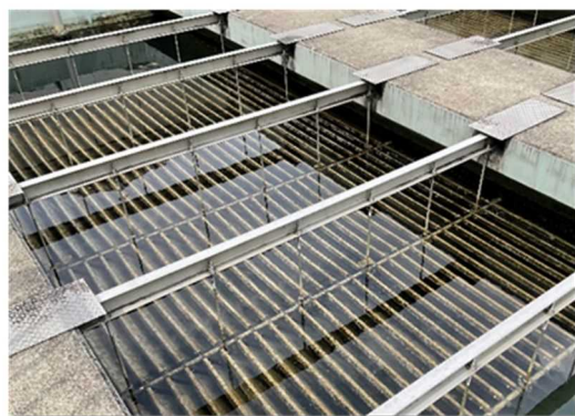
傾斜板沈澱池
