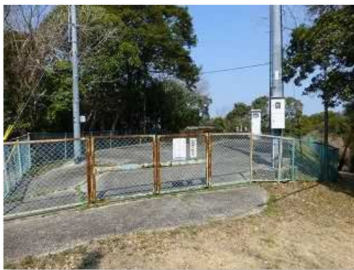
西部第1配水池
