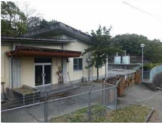
阿村浄水場 外観
