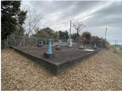
豊後谷配水池
