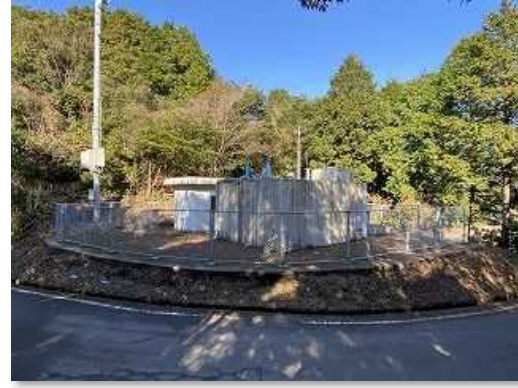
大作山配水池
