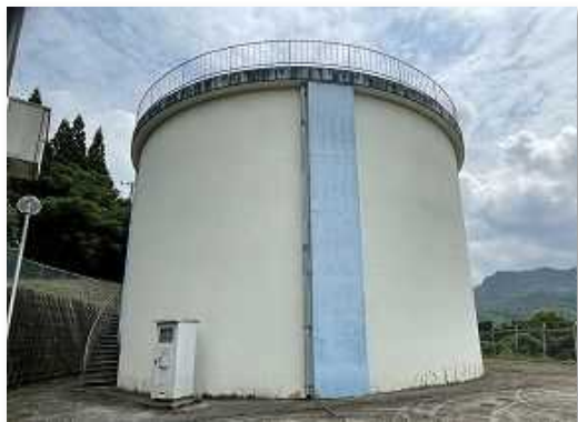
松の元配水池
