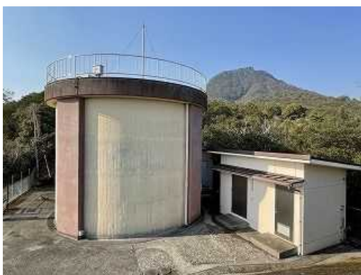
高串配水池-C
