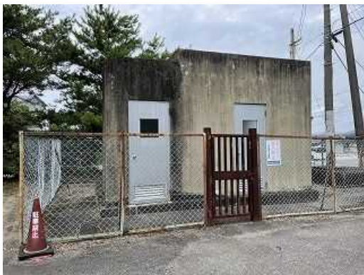
前島ポンプ場
