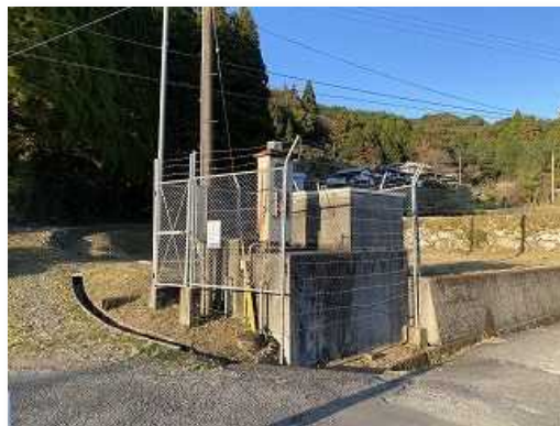
持田ポンプ場
