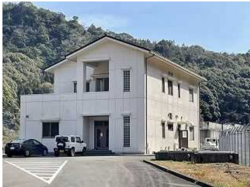
倉江浄水場 外観
