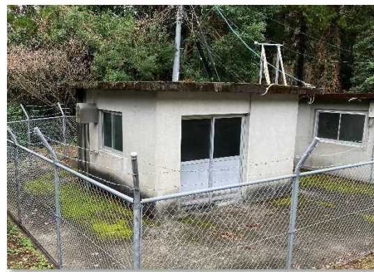
浦山ポンプ場
