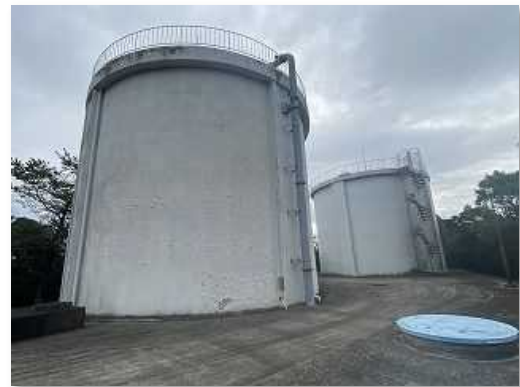
南部第2配水池
