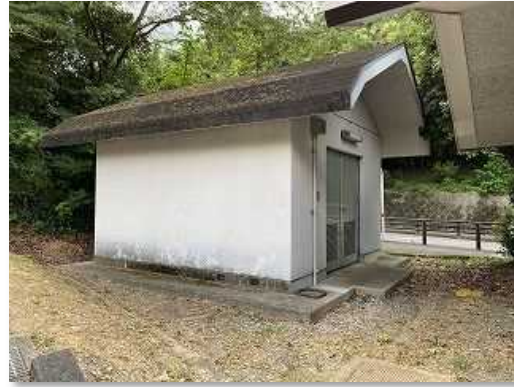
樋合ポンプ場制御室
