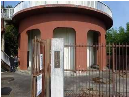
南部第1配水池
