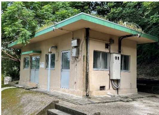
西部ポンプ場
