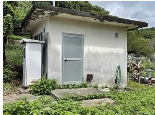
高串ポンプ場
