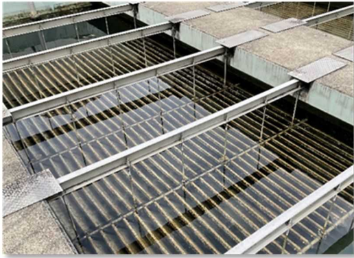
傾斜板沈澱池
