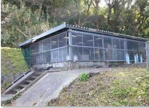
湯島浄水場 外観
