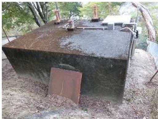
千巖山配水池
