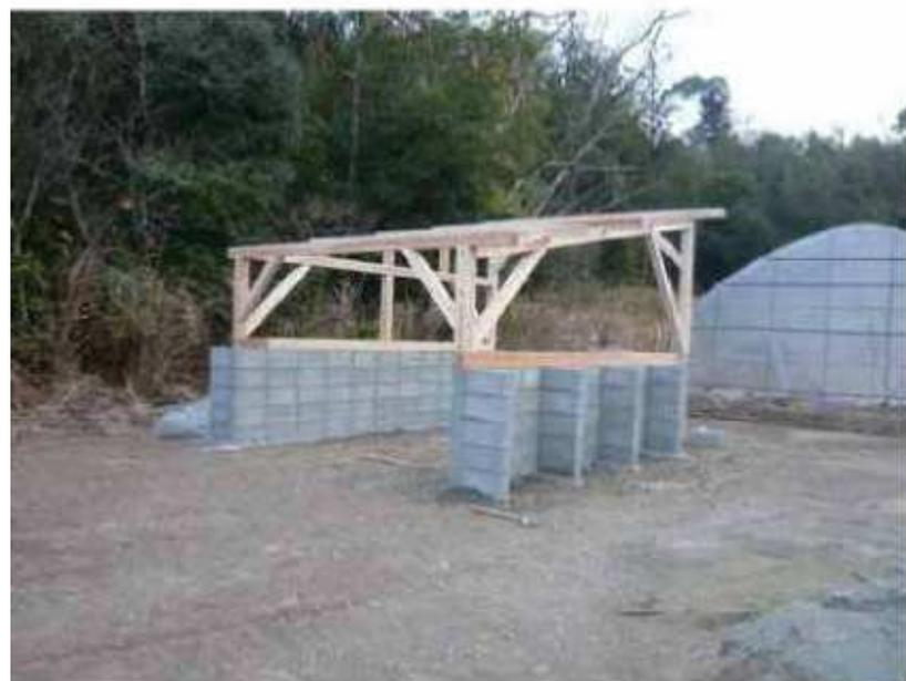
炭焼き釜に直接雨が降込むと釜の管理上支障を来たすため、屋根を取り付ける必要があった。
