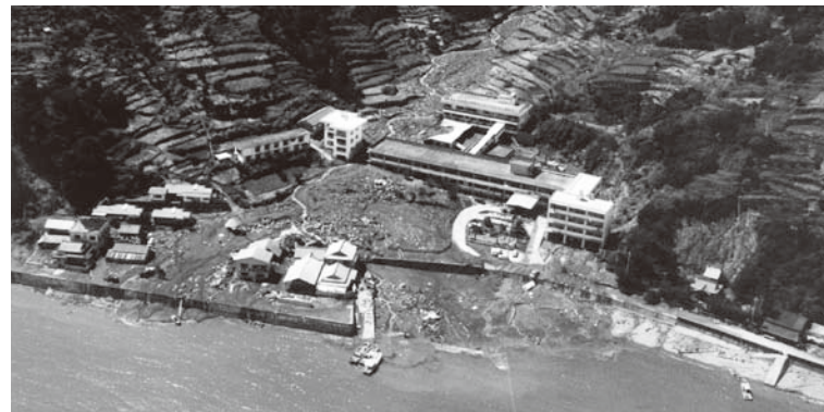
▲水害時の様子
