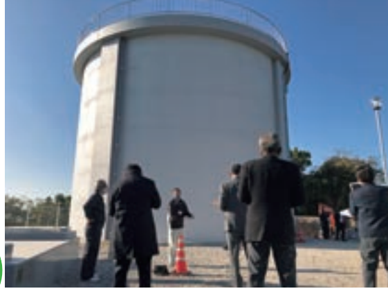
▲中央配水池を現地踏査
