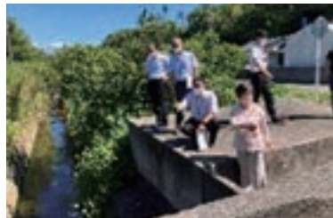
▶現地踏査（経済建設）江後地区中央排水路
