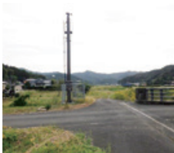
▲三石橋横の監視カメラ
