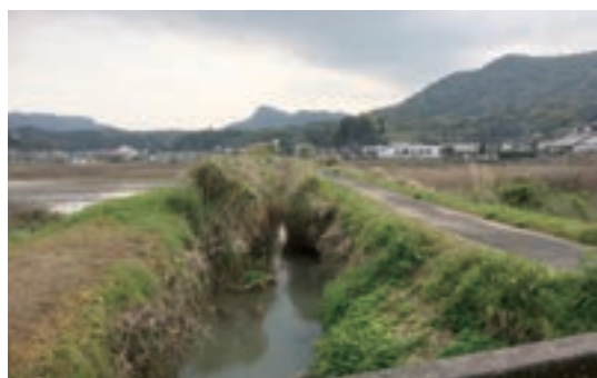
▲整備が望まれる合津川
