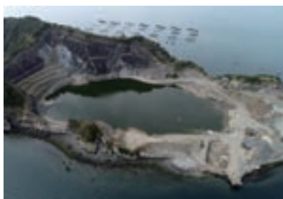
▲竹島土砂処理場（ドローンで撮影）
