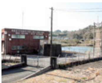
▲排水機場と調整池
