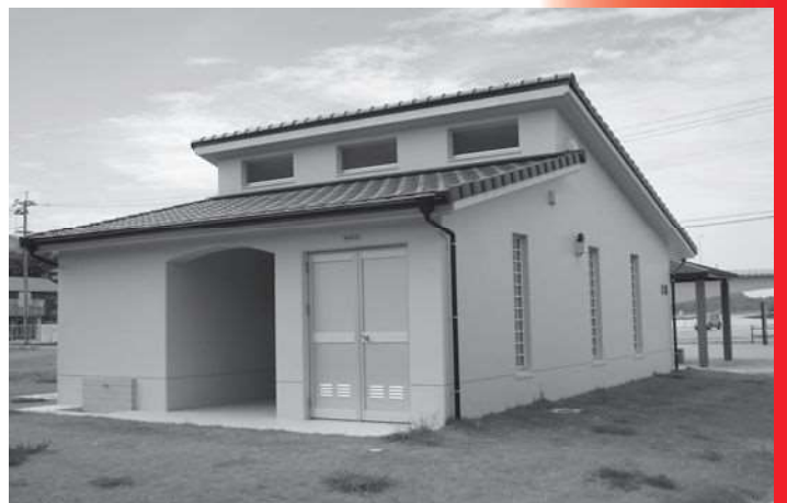
▲前島地区屋外トイレ
