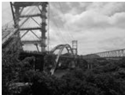
建設中の新1号橋
