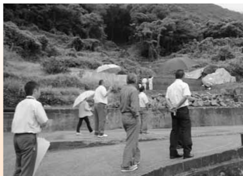
▲ 岩谷地区災害復旧現場
