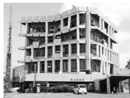
▲被災した宇土市役所
