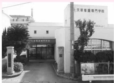
▲旧看護学校(解体中)
