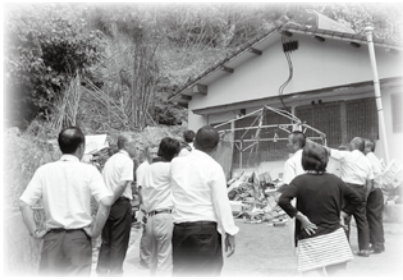
9月11日現地踏査 (住宅裏土砂崩れ現場)
