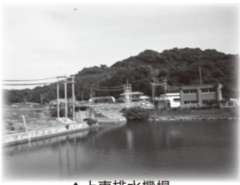
▲上東排水機場
