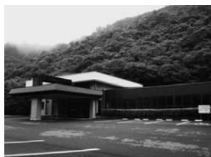
▲上天草市斎場 (屋上に太陽光パネル設置)
