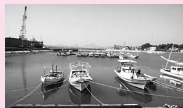
阿村港の改修工事
