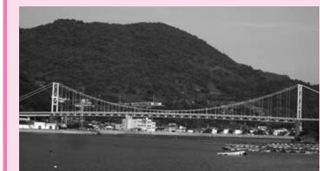
樋島大橋補修
