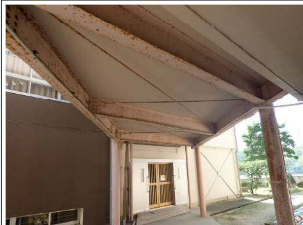
外壁：特別教室棟 柱の破損
