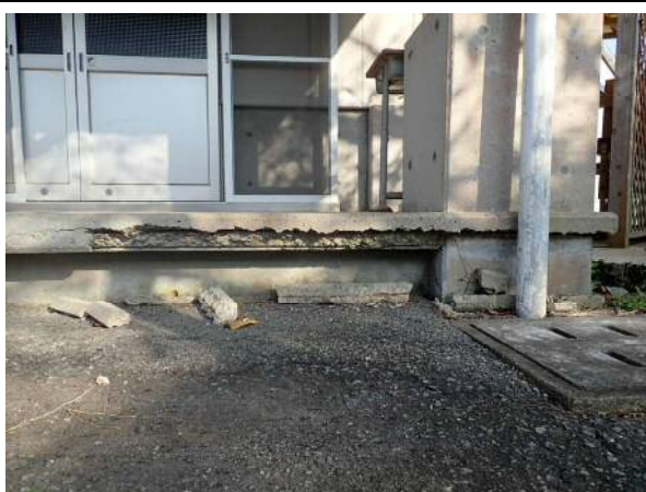
外壁：調理場 土間コンクリート欠落
