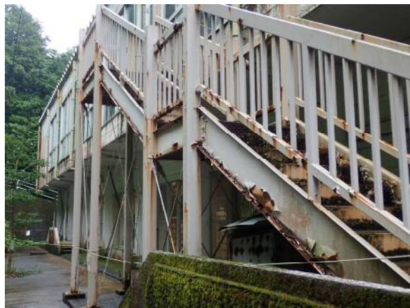
外壁：屋内運動場 外階段前面にサビの進行
