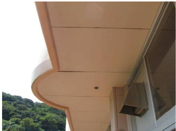
外壁：調理場 軒天 鉄筋露出
