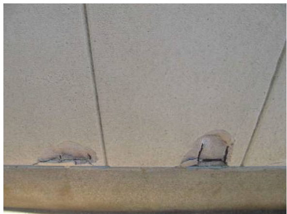
外壁：調理場 軒天 鉄筋露出
