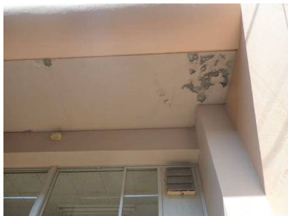
外壁：校舎 ベランダ 塗装の剥がれ
