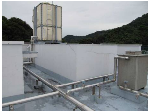
外壁：昇降口 壁面にクラック
