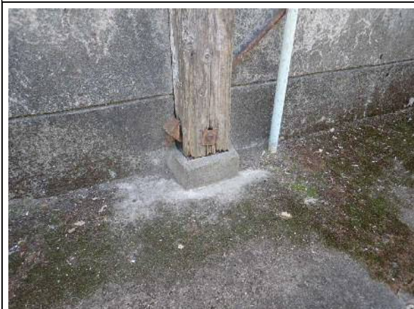
外壁：特別教室棟 柱の破損
