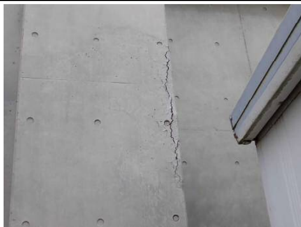
外壁：屋内運動場 壁面にクラック
