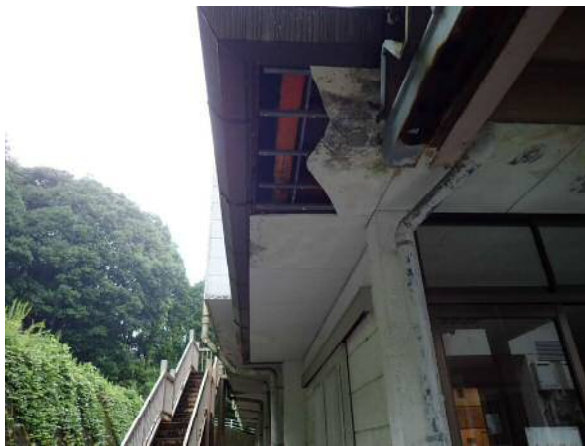
外壁：屋内運動場 軒天破損
