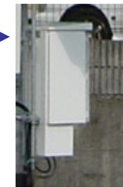
観測装置内にはデータ変換装置、電源部、バッテリー、回線接続機器を収納します。
