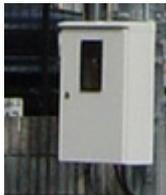
落雷対策のため電源および伝送路用の避雷ユニット収められています。
