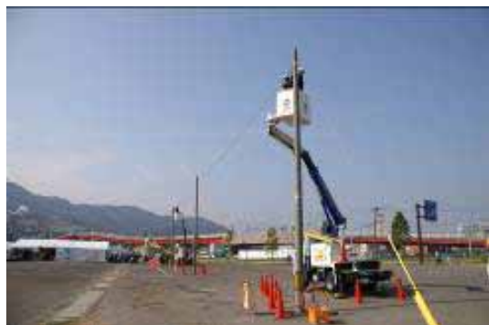
光ケーブル復旧訓練
