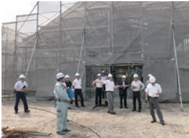
▶前島観光拠点施設の工事進捗状況を確認
