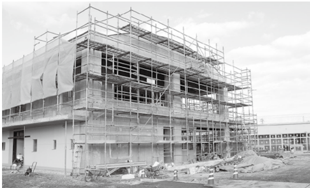
▲建設中の龍ヶ岳保育園
