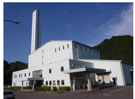
■ 中間処理施設
