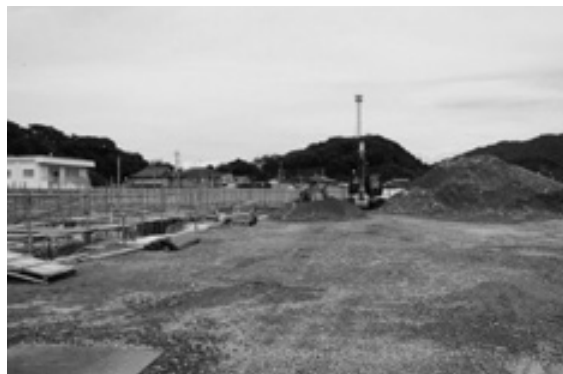
▲ (仮称) 龍ヶ岳保育園舎建設地
