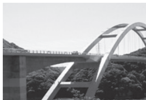
▲5月に開通した天城橋
