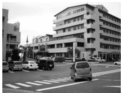
上天草総合病院の駐車場
