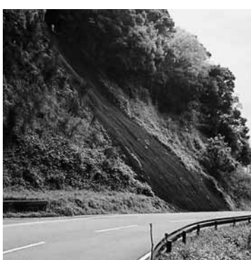
質問した工事箇所
