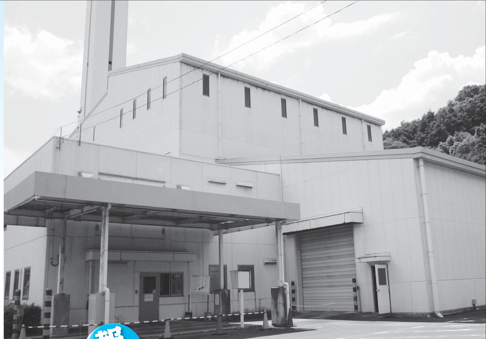
天草広域連合松島地区清掃センター
