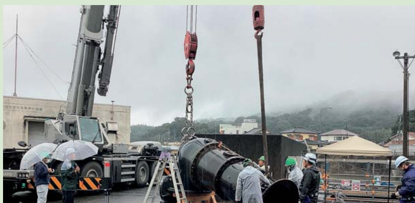
▲今津排水機場（ポンプ設備）復旧工事の様子
