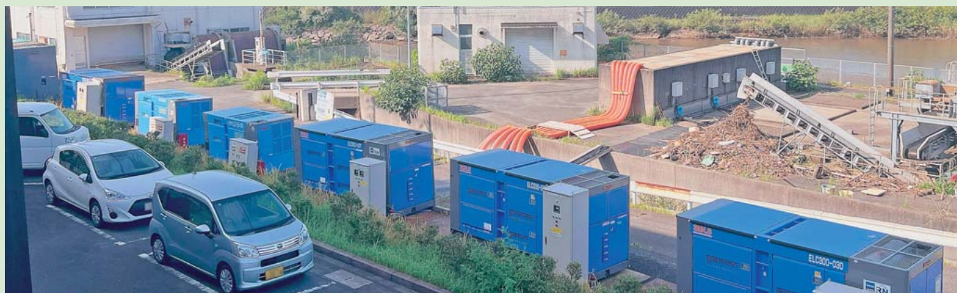
▲今津排水機場の仮復旧工事後の様子。全排水機場に仮設ポンプを設置。
