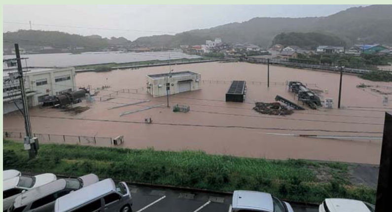
▲被災時の合津・今津排水機場付近（松島町）
