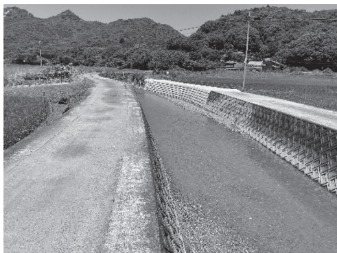
▲復旧工事後の今泉川
