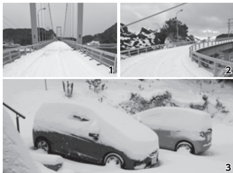
1. 2. 雪に覆われた樋島大橋 3. 雪に埋もれた車（龍ヶ岳）
