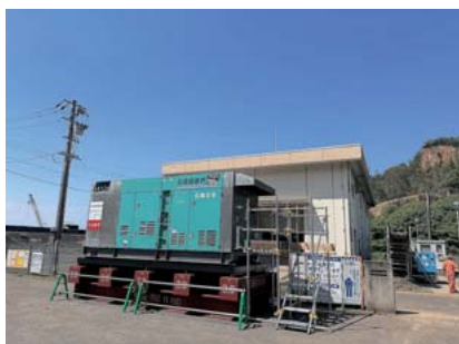
◀昨年8月の豪雨により機能停止していた農業用排水機場も、被災前までの機能に復旧しています。(写真：今泉排水機場の仮設ポンプ)
