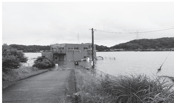
▲阿村排水機場
