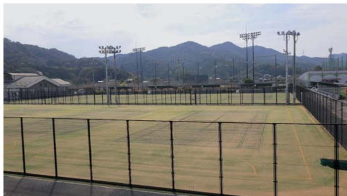
復旧後のテニスコート
