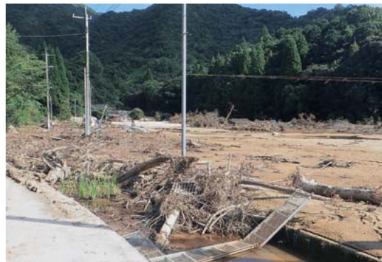
後山地区農地・水路の被災
