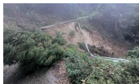
市道合津牟田線の土砂崩れ
