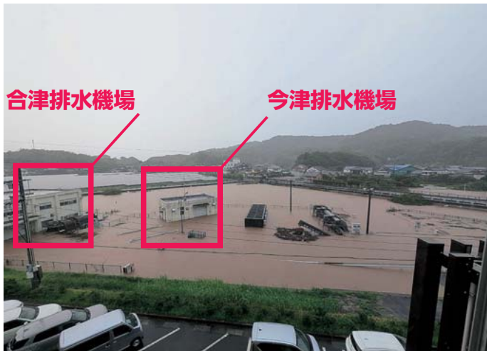
令和7年8月11日の合津・今津排水機場
