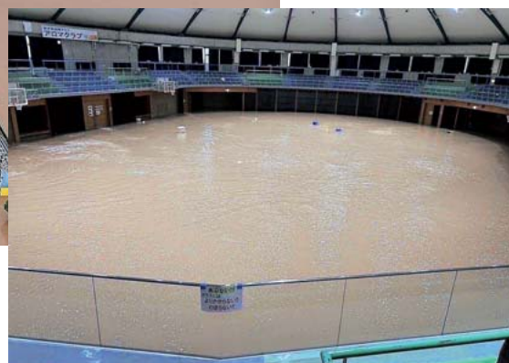
松島総合センター「アロマ」アリーナの浸水
