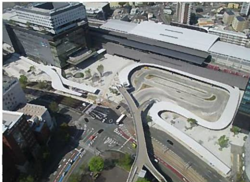
熊本駅 白川口駅前広場の整備
