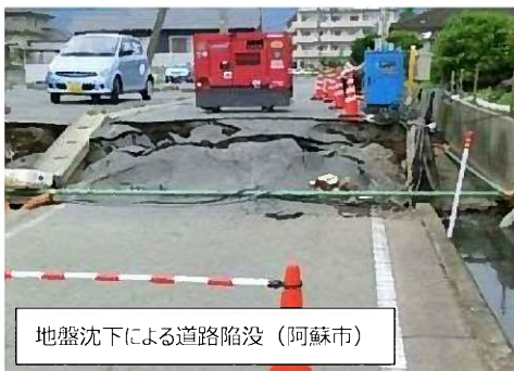
図 下水道施設の被災状況
