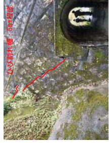
ブロック積み構壁の変状(終点側)
